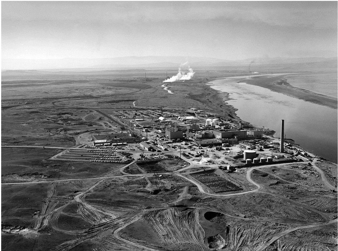
(ハンフォード工場 写真出典： https://en.wikipedia.org/wiki/Hanford_Site )
