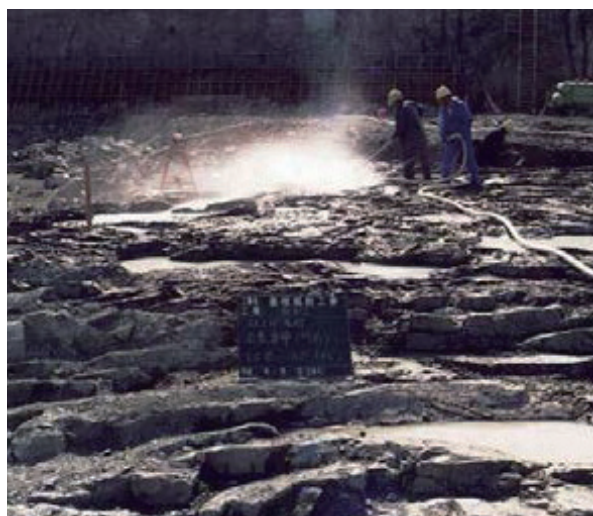
3号機の基礎岩盤
