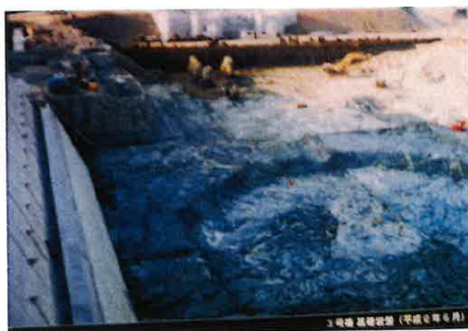
図9 「伊方ビクターズハウス」に展示されている3号機建設当時の基礎部分の写真。
