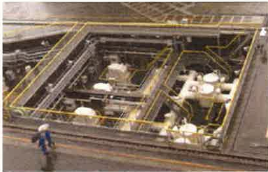
海水ピットポンプ室（飛来物対策前）
