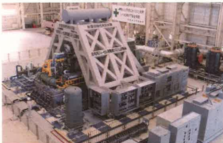
【ディーゼル発電機】 (非常用ディーゼル発電機システム)
