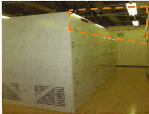
支持構造物の取付
