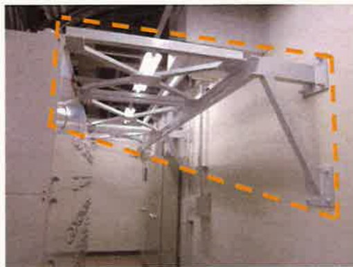
電気盤支持構造物取付け
