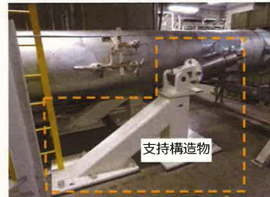
支持構造物追設
