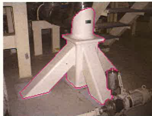
支持構造物取替
