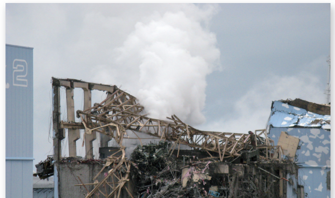
2011年3月11日東電福島第一原発事故。水素爆発で破壊された原子炉建屋から放射能を大量に含んだ白煙をもうもうと吹き上げる3号機。私たちは福島原発事故の教訓を決して忘れるべきではありません。 【画像出典】東京電力 web サイトより
