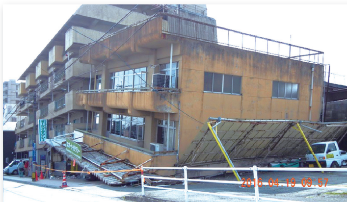
最大地震動1500ガル以上の地震動が立て続けに襲った熊本地震の惨状。新建築基準を満たした建物は多くが全壊・倒壊を免れた。 【画像出典】熊本素材写真アーカイブス「キロクマ」より https://kumamoto.photo/archives/
