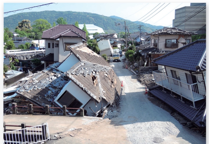
最大地震動1500ガル以上の地震動が立て続けに襲った熊本地震の惨状。新建築基準を満たした建物は多くが全壊・倒壊を免れた。 【画像出典】熊本素材写真アーカイブス「キロクマ」より https://kumamoto.photo/archives/
